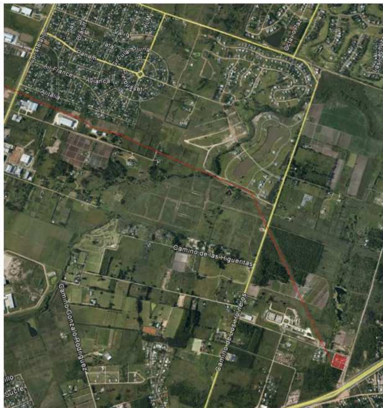
Figura 8- Línea de alta tensión y subestación de UTE, fuente Google Earth, fecha setiembre 2015
