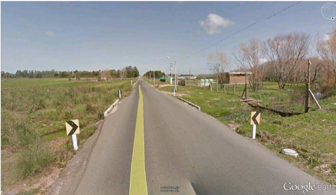
Figura 2. Fotografía puente sobre Cmno de los Horneros, fuente Google Earth, fecha setiembre 2015
