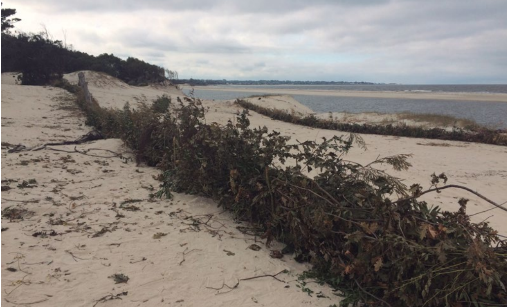
Pantallas de regeneración dunar o cercas captoras de arena, colaboran con la formación de dunas y la conservación de las playas. Es importante cuidarlas, no usar para prender fuego ni tirar residuos.
